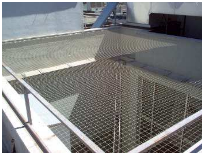
Installazione rete antintrusione cavedio condominiale
