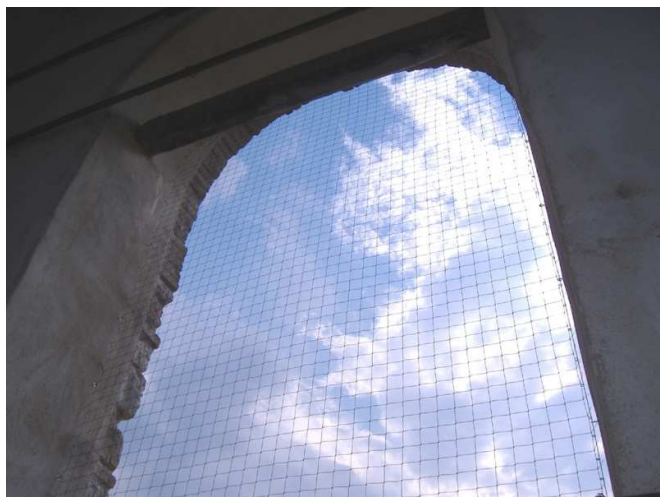
Installazione rete antintrusione campanile
